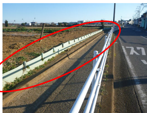
○ 対策例：畑に土留め板を設置
