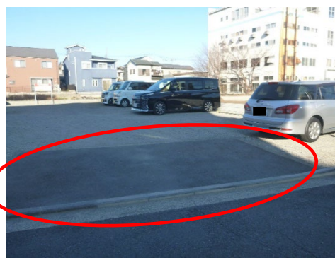
○ 対策例：駐車場出入口を舗装
